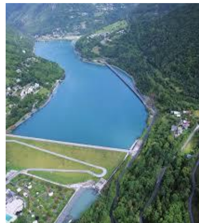
Bassin inférieur : barrage du Verney
