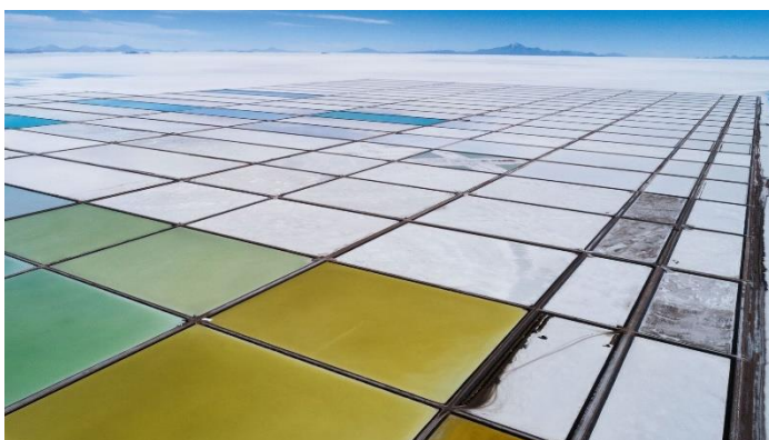
Bassins d'évaporation d'une usine de lithium en Bolivie.
